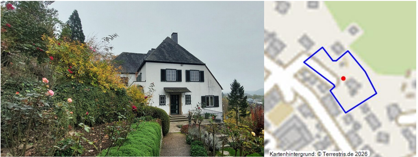
Blick über einen Teil des umgebenden Gartens auf das Adenauer-Wohnhaus in Bad Honnef-Rhöndorf (2024). Fotograf/Urheber: Franz-Josef Knöchel
