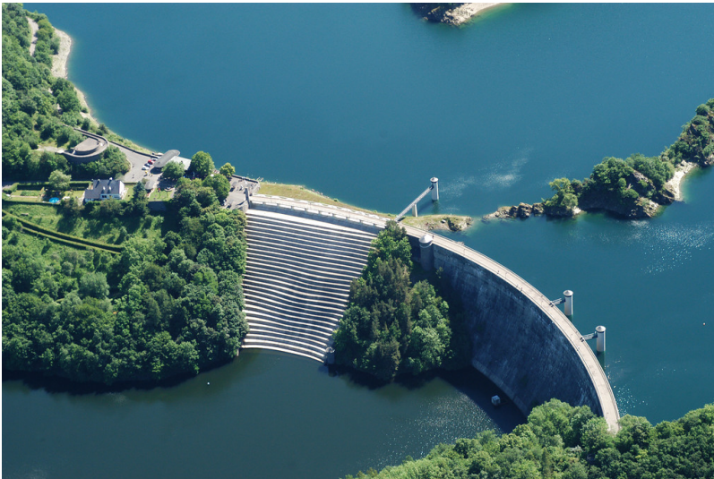
Schleiden, Urfttalsperre Fotograf/Urheber: Wasserverband Eifel-Rur
