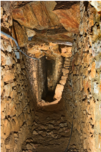
Blankenheim. Tiergartentunnel (2011) Fotograf/Urheber: Thuns, Michael
