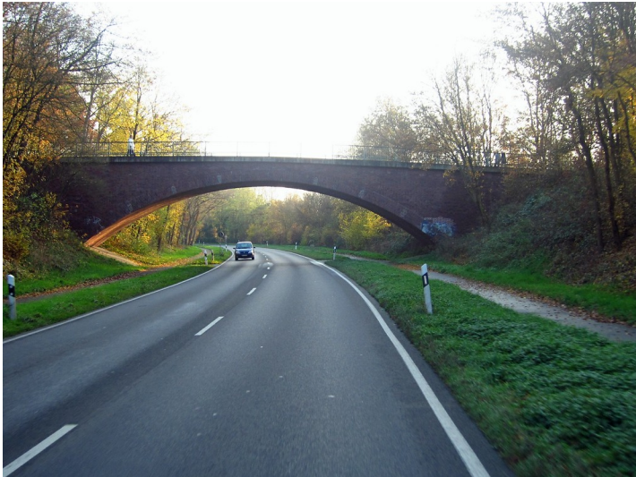
Die frühere Rennstrecke "Grenzlandring" (Wegbergring) an der L3 bei Wegberg (2012). Fotograf/Urheber: Knöchel, Franz-Josef
