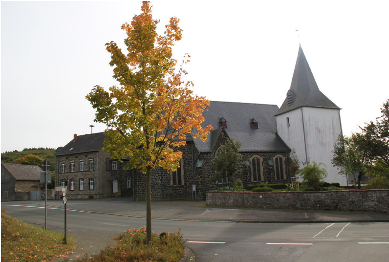
Pfarrkirche St. Luzia in Uess (2012) Fotograf/Urheber: Peter Burggraaff
