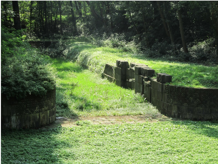
Straelen, Kr. Kleve, Schleuse Louisenburg Fotograf/Urheber: Weber, Claus
