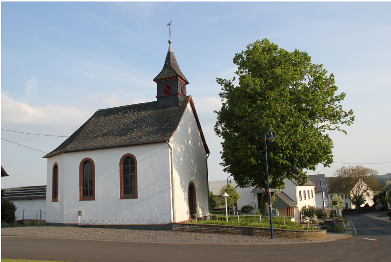
St. Wendelinuskapelle in Gelenberg (2014) Fotograf/Urheber: Peter Burggraaf
