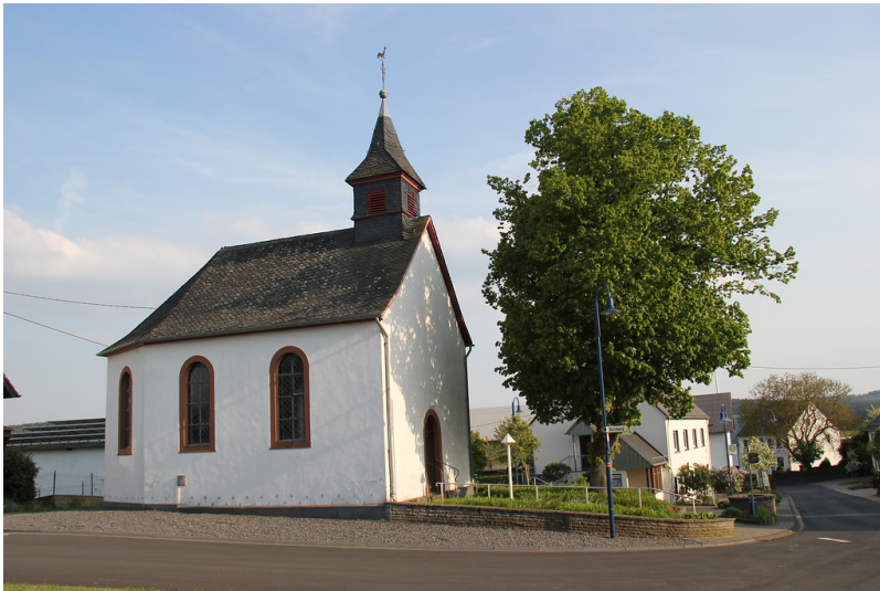
St. Wendelinuskapelle in Gelenberg (2014) Fotograf/Urheber: Peter Burggraaf
