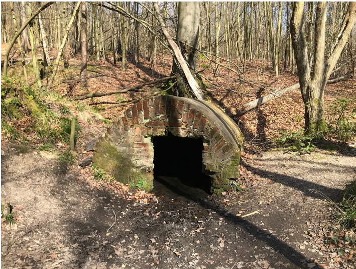
Der halbrund gemauerte Schöpfbunker der Quelle Klingelpütz wurde 1944 errichtet (2020). Fotograf/Urheber: Nicole Schmitz
