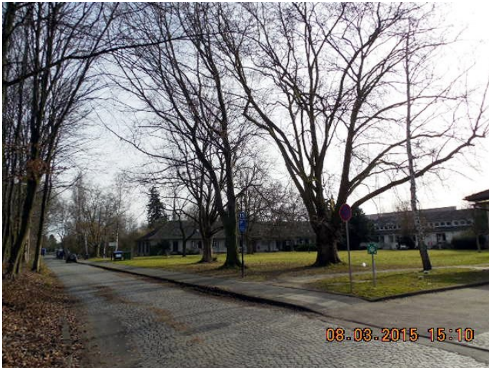
Erhaltene Straßentrasse des ehemaligen Flugplatzes Ostheim in Köln-Merheim (2015) Fotograf/Urheber: Klaus-Dieter Kleefeld
