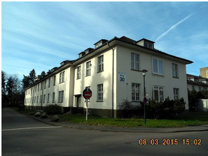
Ein Gebäude (ehemaliger Kasernenbau) des ehemaligen Flugplatzes Ostheim in Köln-Merheim (2015) Fotograf/Urheber: Klaus-Dieter Kleefeld
