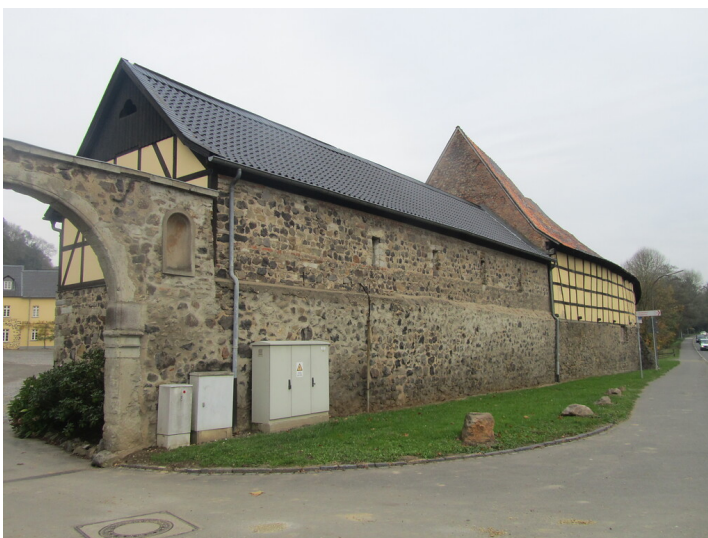
Die Wirtschaftsgebäude von Gut Marienforst sind aus Bruchsteinmauerwerk und in Fachwerkbauweise errichtet (2014) Fotograf/Urheber: Nicole Schmitz
