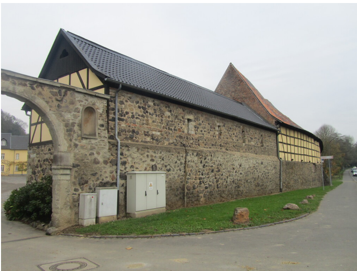
Die Wirtschaftsgebäude von Gut Marienforst sind aus Bruchsteinmauerwerk und in Fachwerkbauweise errichtet (2014) Fotograf/Urheber: Nicole Schmitz
