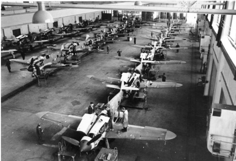
Historische Aufnahme von 1943: Produktion des von 1936 bis 1945 gebauten Jagdflugzeugs Messerschmitt Bf 109 bzw. Me 109, welches unter anderem auf dem Flugplatz Ostheim in Köln-Merheim zum Einsatz kam. Fotograf/Urheber: Höss
