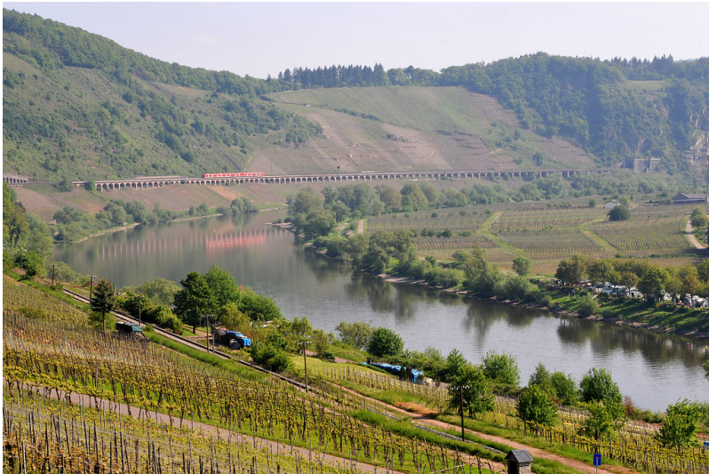
Das von Weinbaulagen umgebene längste Hangviadukt Deutschlands gegenüber der Ortschaft Pünderich an der Mosel (2010). Fotograf/Urheber: Christian Kleis
