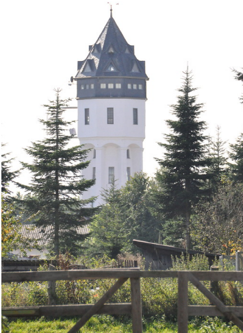
Wasserturm in Rösberg (2014) Fotograf/Urheber: Nicole Schmitz
