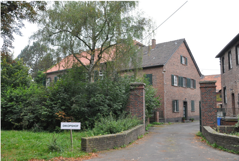
Toreinfahrt zum Dickopshof (2014) Fotograf/Urheber: Nicole Schmitz
