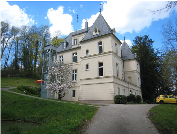
Haus Mörner in Bornheim-Roisdorf (2016), Südostansicht. Fotograf/Urheber: Jutta Stiens
