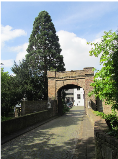
Tor und Steinbrücke der Wasserburg Gleuel (2014) Fotograf/Urheber: Nicole Schmitz
