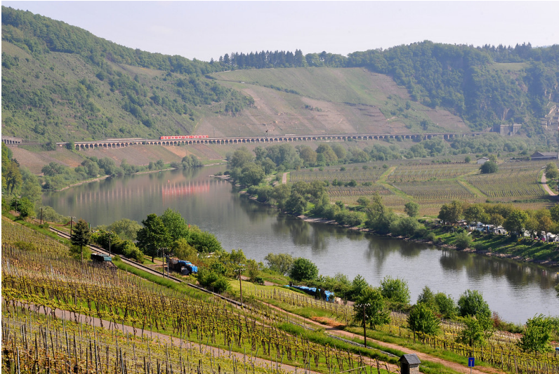
Das von Weinbaulagen umgebene längste Hangviadukt Deutschlands gegenüber der Ortschaft Pünderich an der Mosel (2010). Fotograf/Urheber: Christian Kleis
