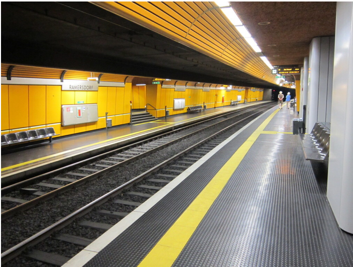
U-Bahn-Hof Ramersdorf in Bonn (2015). Bahnsteige Richtung Bonn (links) und Bad Honnef (rechts) Fotograf/Urheber: Claus Weber
