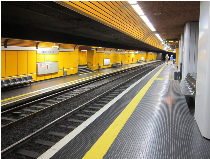
U-Bahn-Hof Ramersdorf in Bonn (2015). Bahnsteige Richtung Bonn (links) und Bad Honnef (rechts) Fotograf/Urheber: Claus Weber
