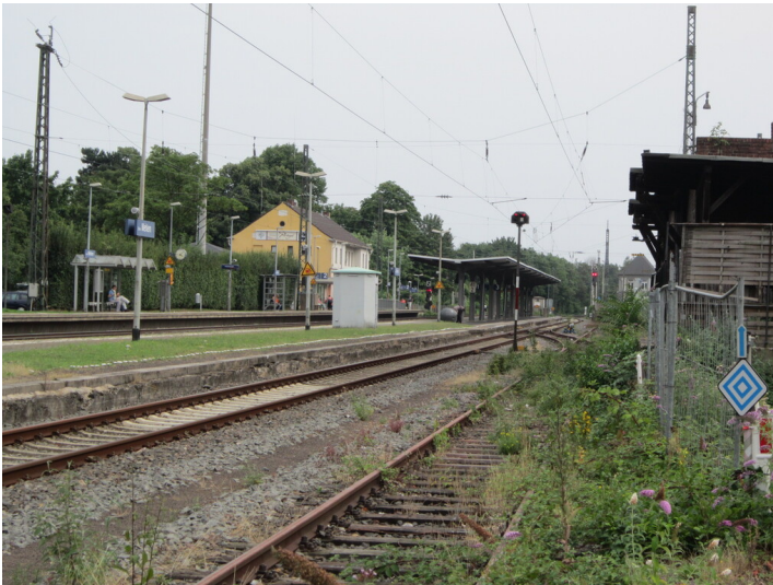
Bahnhof Mehlem in Bonn (2015) Fotograf/Urheber: Claus Weber
