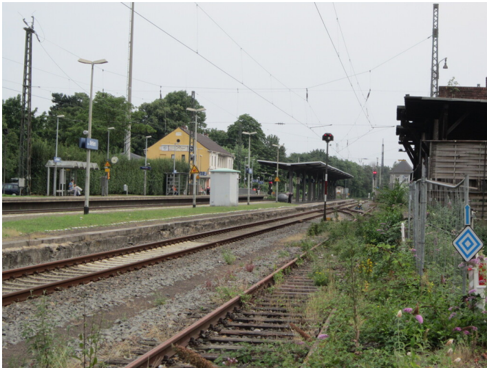
Bahnhof Mehlem in Bonn (2015) Fotograf/Urheber: Claus Weber
