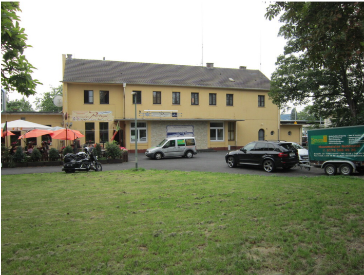
Bahnhof Mehlem in Bonn, Straßenseite (2015) Fotograf/Urheber: Claus Weber
