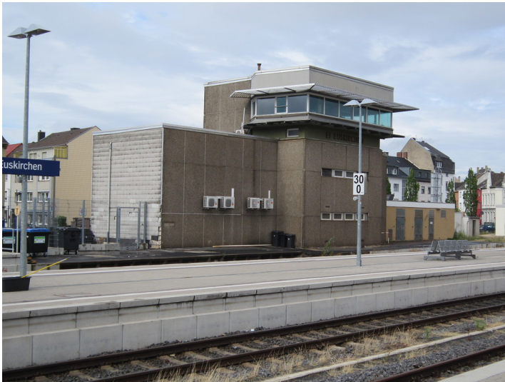
Bahnhof Euskirchen, Stellwerk Ef von der Gleisseite (2015) Fotograf/Urheber: Claus Weber
