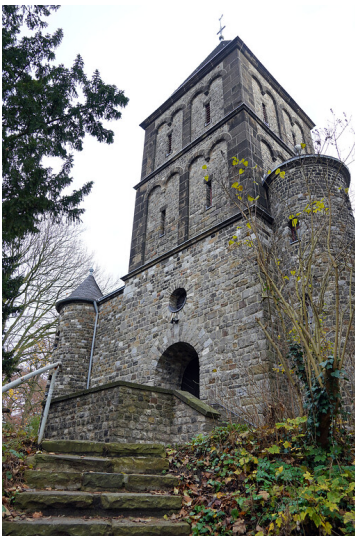
Die Kirche des ehemaligen Frauenklosters Sankt Salvator auf dem Salvatorberg im Stadtbezirk Aachen-Mitte (2021). Fotograf/Urheber: Katharina Grünwald
