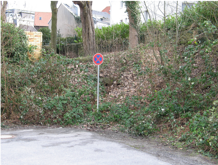
Abschnitt der Stiftsmauer in Essen-Rellinghausen (2011) Fotograf/Urheber: Claus Weber
