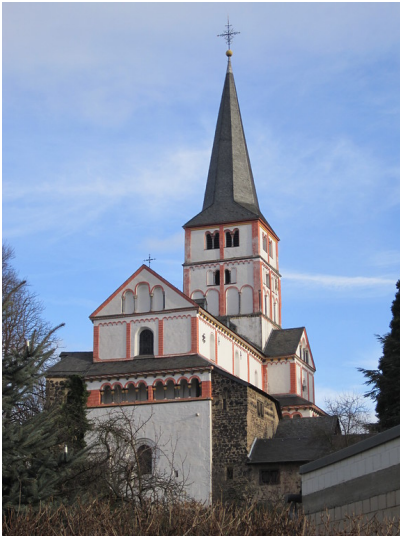
Die Doppelkirche in Schwarzrheindorf von Westen Fotograf/Urheber: Wolff, Anna
