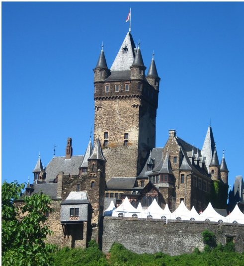
Blick auf den Zentralbau mit dem Hauptturm (Bergfried) der Reichsburg Cochem, Ansicht aus westlicher Richtung (2015). Fotograf/Urheber: Franz-Josef Knöchel
