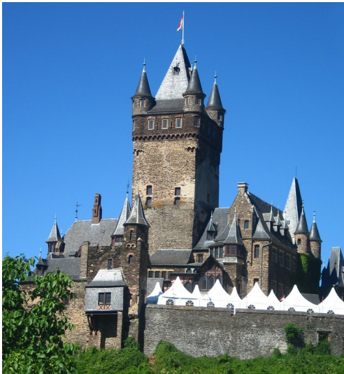
Blick auf den Zentralbau mit dem Hauptturm (Bergfried) der Reichsburg Cochem, Ansicht aus westlicher Richtung (2015). Fotograf/Urheber: Franz-Josef Knöchel
