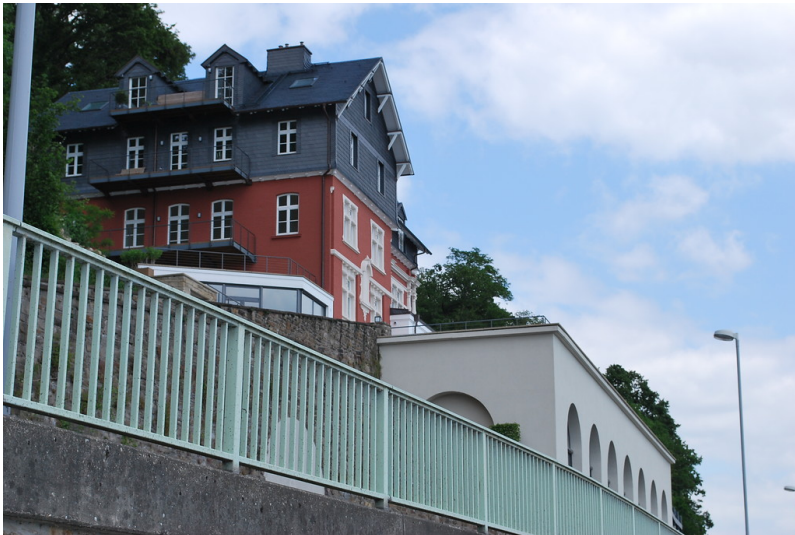
Das ehemals als Jugendherberge genutzte Gebäude von 1889 liegt direkt an der Ruhr. Heute befinden sich dort Luxuswohnungen (2015). Fotograf/Urheber: Martina Gelhar
