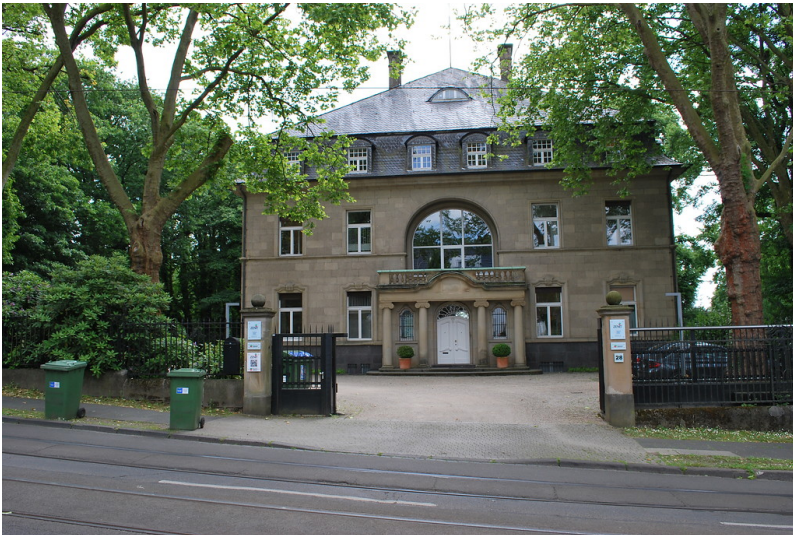
Haus Urge ist eine zweigeschossige Unternehmervilla aus dem Jahr 1913. Das Haus wurde auf quadratischem Grundriss im Stil des Neobarock am Ruhrtalhang errichtet und ist von einem Park umgeben. Zu sehen ist hier die Straßenansicht (2015).
