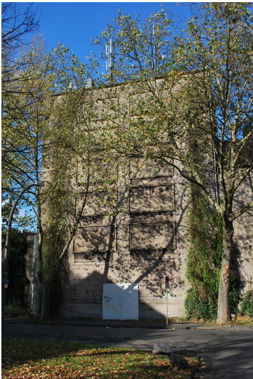
Der Hochbunker steht in der Siedlung Margarethenhof an der Hochfelder Straße. Im Zweiten Weltkrieg sollte an der Stadt Rheinhausen die optimale Versorgung der Bevölkerung mit Bunkern demonstriert werden (2013). Fotograf/Urheber: Gelhar, Martina
