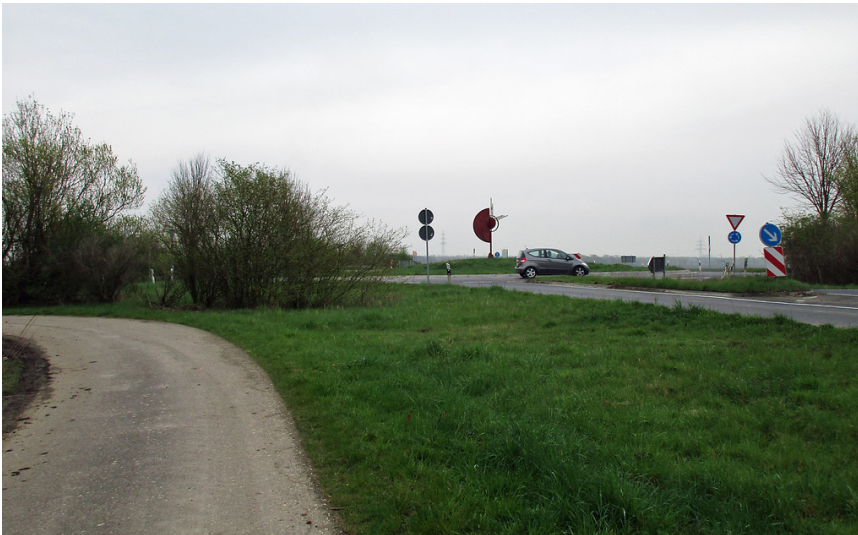
Der Verkehrskreisel bei Pulheim-Sinnersdorf mit der Einmündung der Roggendorfer Straße in die Landstraße L 183 (2016). Fotograf/Urheber: Franz-Josef Knöchel
