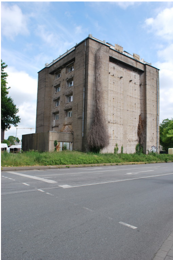
Hochbunker an der Ecke Friedrich-Alfred-Straße / Atroper Straße in Duisburg-Rheinhausen (2015). Fotograf/Urheber: Martina Gelhar
