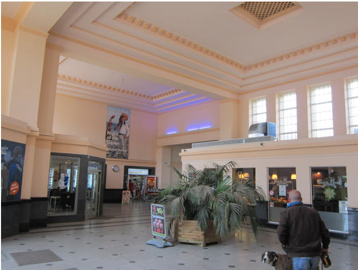
Bahnhof Viersen (2015). Innenansicht nach der Restaurierung Fotograf/Urheber: Claus Weber
