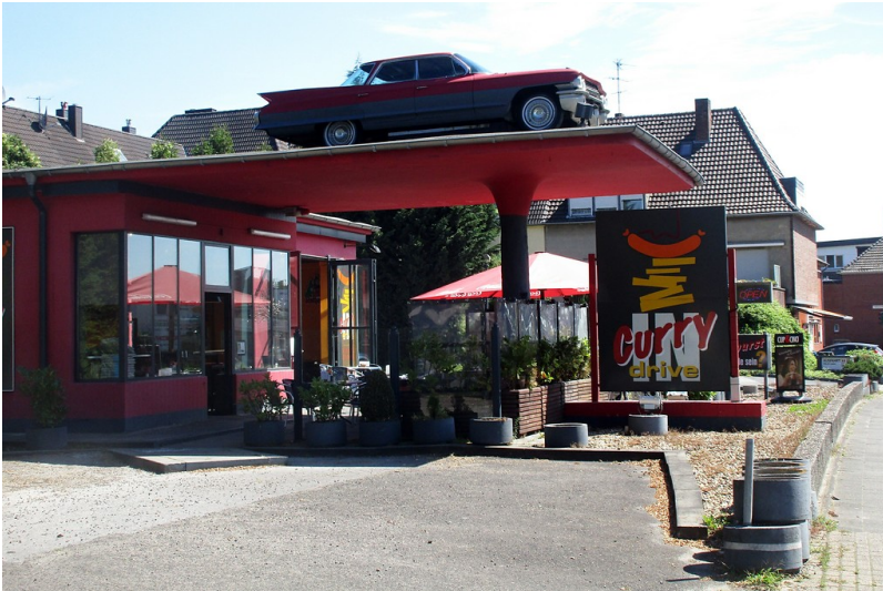
Heute als Schnellrestaurant "Curry-Drive-In" genutzte historische Tankstelle in der Freiheitsstraße in Viersen (2017). Fotograf/Urheber: Franz-Josef Knöchel
