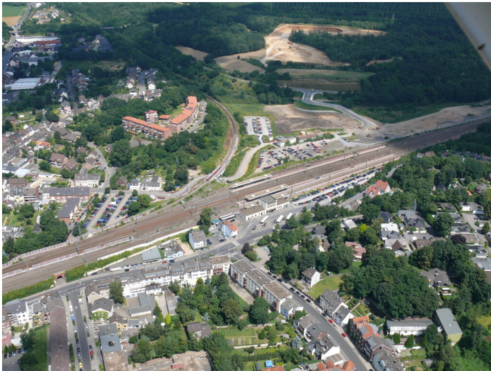
Bahnhof Horrem (2008). Luftbild Richtung Nordosten. Nach links die Bahnstrecke nach Aachen/Liblar, nach rechts die Strecke nach Köln, nach oben links die Strecke nach Bergheim. Durch die Unterführung links unten fuhr ehemals die Bergheimer Kreisbahn. Fotograf/Urheber: Heinrich Mach
