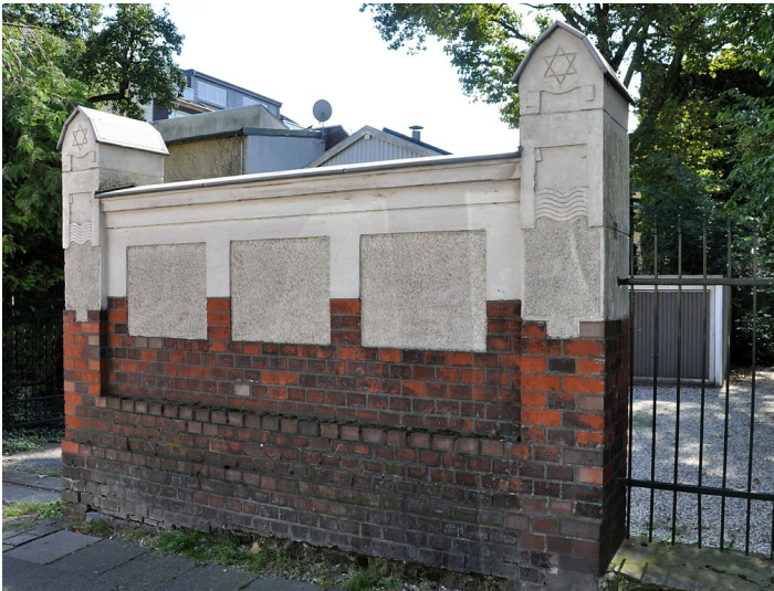
Teillabschnitt der Mauerreste des jüdischen Friedhofs Rheinbrückenstraße in Ruhrort (2016).
