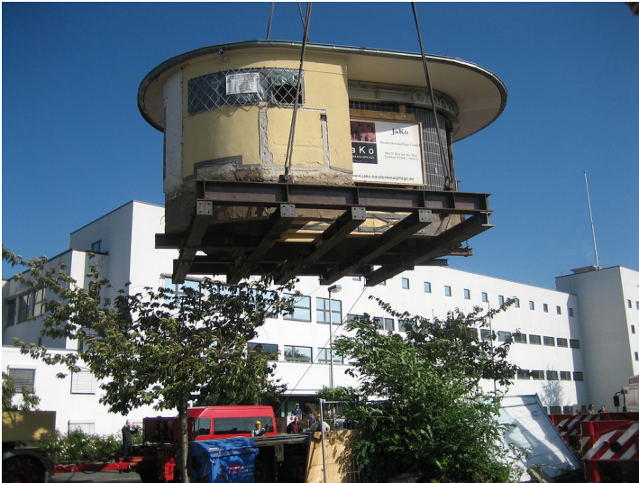
Ein Kran hebt das denkmalgeschützte "Bundesbüchchen", einen Kiosk im Bonner Regierungsviertel an, um diesen zu seinem Zwischenlager, einem Bauhof in Hersel, transportieren zu können (2006). Fotograf/Urheber: Wolfgang Schlesener
