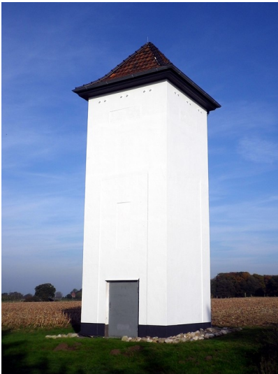
Westansicht des Transformatorengebäudes in Schermbeck-Besten, der Weiße Turm Besten von der Straßenseite, an der Kirchhellener Straße in Blickrichtung Dorsten (2014). Fotograf/Urheber: Poßer, Christian
