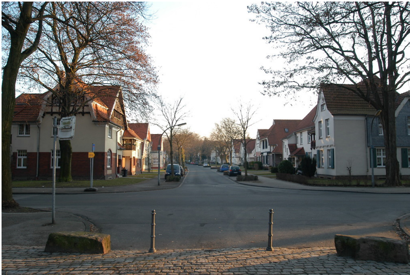
Siedlung Teutoburgia in Herne (2006) Fotograf/Urheber: Kai-William Boldt
