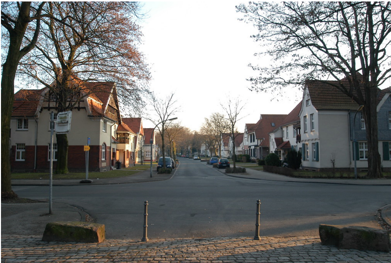
Siedlung Teutoburgia in Herne (2006) Fotograf/Urheber: Kai-William Boldt
