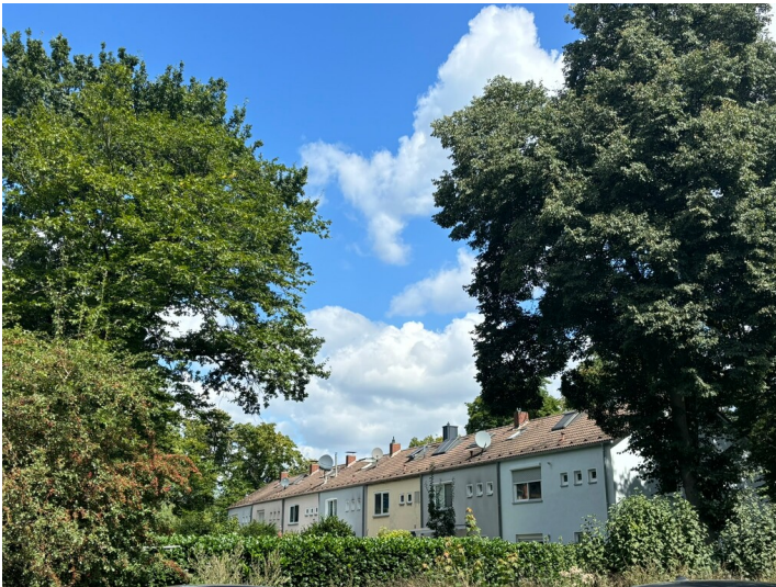
Besatzungssiedlung Dellbrück (2024) Fotograf/Urheber: Carolin Ehret
