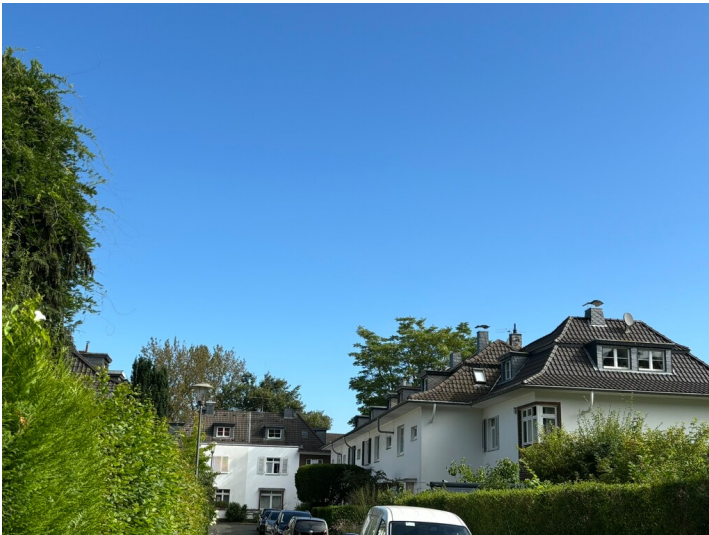
Reichsheimstättensiedlung Dellbrück (2024) Fotograf/Urheber: Carolin Ehret
