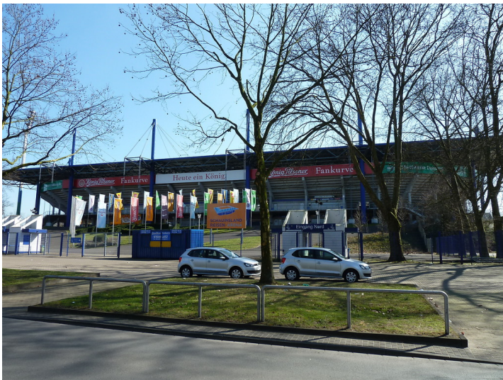
Schauinsland-Reisen-Arena (ehemaliges Wedaustadion) in Duisburg (2012) Fotograf/Urheber: Kai-William Boldt
