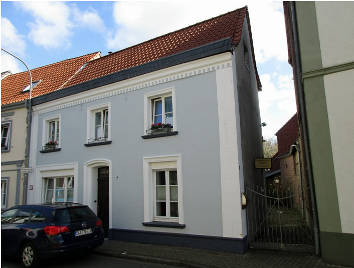
Das ehemalige jüdische Schulhaus mit der dahinter befindlichen Synagoge mit jüdischer Mikwe (Ritualbad) in der Kapellener Straße in Issum, heute Gedenkstätte (2016). Fotograf/Urheber: Felicitas Gildenhard
