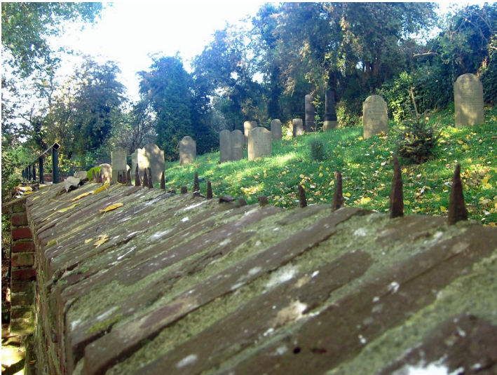
Gräberfeld und Friedhofsmauer auf dem Jüdischen Friedhof am Stromberg in Jüchen-Hochneukirch (2013). Fotograf/Urheber: Knöchel; Franz-Josef
