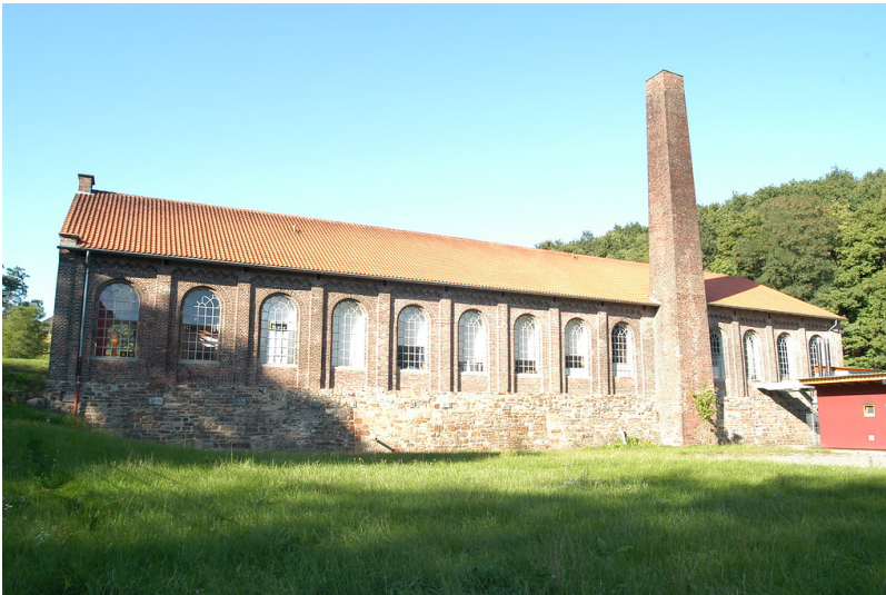
Maschinenhalle der Harkortschen Fabrik (2006) Fotograf/Urheber: Kai-William Boldt
