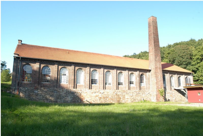
Maschinenhalle der Harkortschen Fabrik (2006) Fotograf/Urheber: Kai-William Boldt
