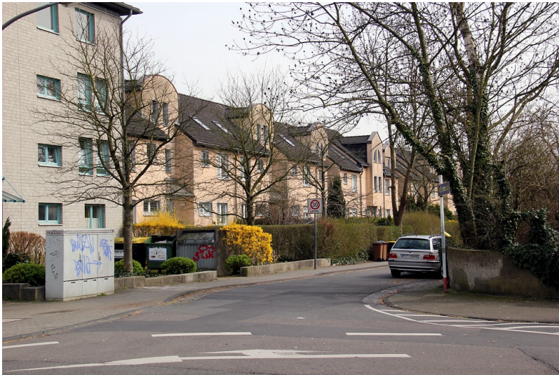
Blick in die Drosselbartstraße in der Märchensiedlung in Köln-Holweide (2015)
